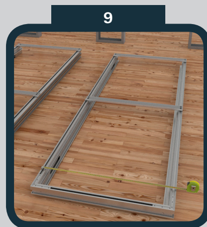
9 Zkontrolujte si konstantnost průchodu po celé výšce zárubně.
