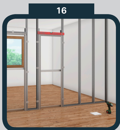
Vyvažte zárubeň horizontálně
