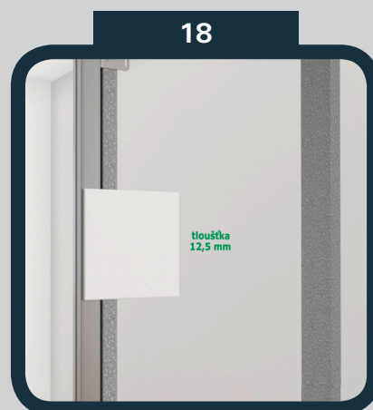
Dočasně upevněte pomocnou SDK deskou a zkontrolujte lícování zárubně s SDK deskou
