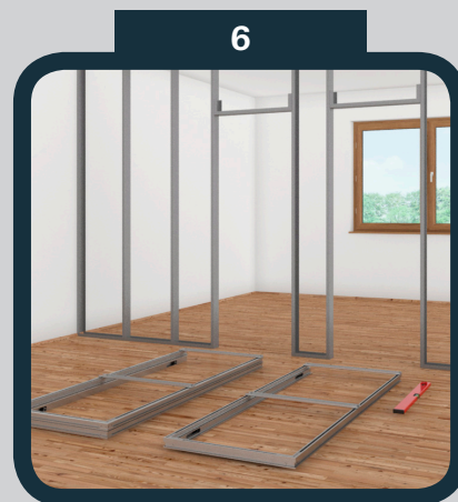
6 Připravená konstrukce SDK pro usazení zárubně
