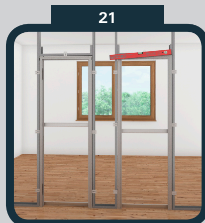
21 Znovu si zkontrolujte vyvážení zárubně horizontálně i vertikálně
