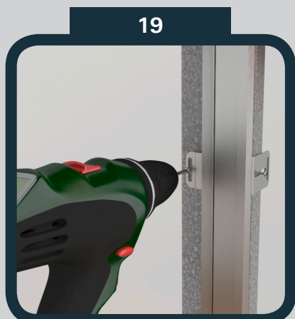
19 Zárubeň přišroubujte přes kotvící plochy k SDK konstrukci
