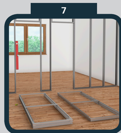
7 Zkontrolujte si správnost stavebního otvoru vertikálně
