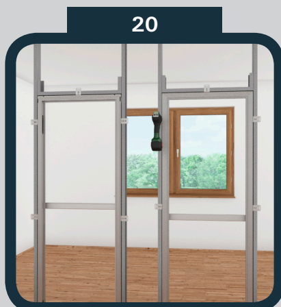
20 Zárubeň přišroubujte přes kotvící plochy k SDK konstrukci
