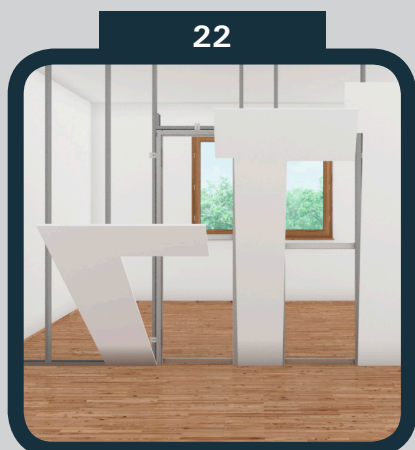
22 Přiložte si SDK k zárubni
