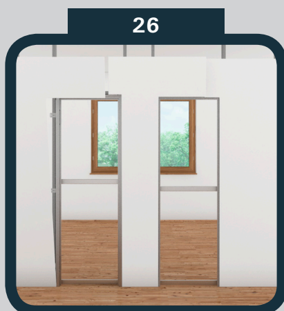
26 Opláštěte zárubeň SDK. Desky SDK nesmí být napojovány v rohu zárubně.
